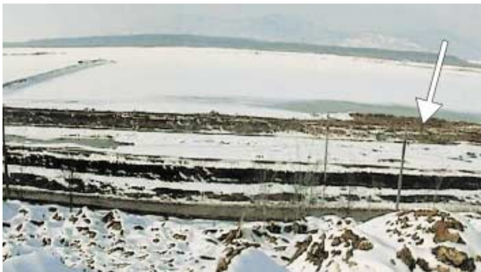
Circa 100 000 m 3 di fango contenente cianuro si sono riversati nel bacino di raccolta della miniera d'oro Aurul, a Baia Mare, nel punto della diga indicato dalla freccia. Il fango è colato attraverso il piccolo fiume (in primo piano nell'immagine) sino ai fiumi Somes, Tibisco e Danubio, raggiungendo infine il Mar Nero, distante 2000 km. Nell'immagine la breccia è arginata con sacchi di sabbia.
